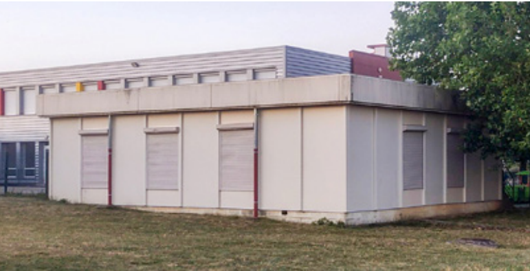
la vieille salle de jeux qui va être déconstruite
